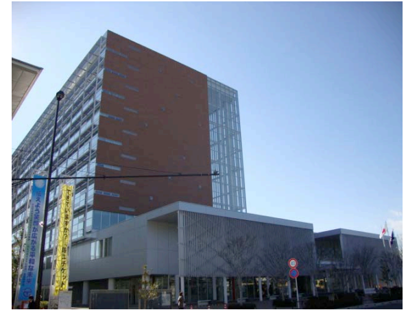
東京都町田市 テラッコッタルーバー
