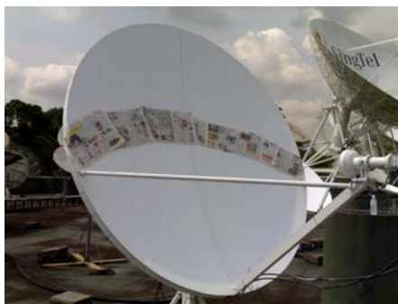
洗浄後、施工箇所を区分
