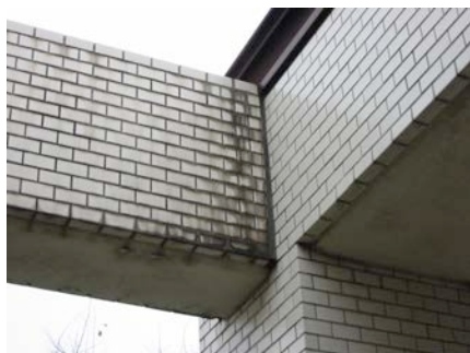
前清掃及び施工 以前
