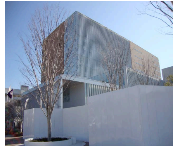
東京都町田市 テラッコッタルーバー
