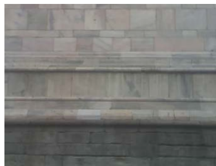
大理石洗浄後施工
